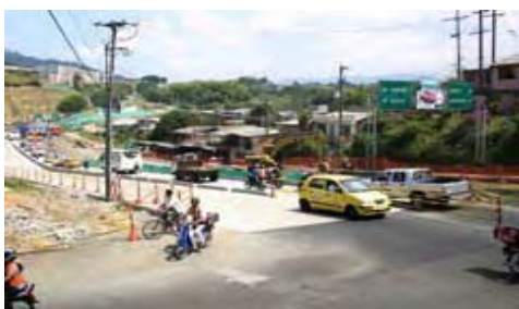
Proceso de obra de la Av. San Mateo
