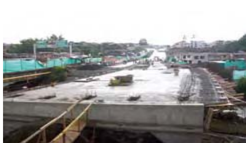
Proceso de obra de la Av. San Mateo
